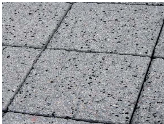
Figura 60. Losa de hormigón abujardada prevista en los cruces peatonales de las macromananzas.
