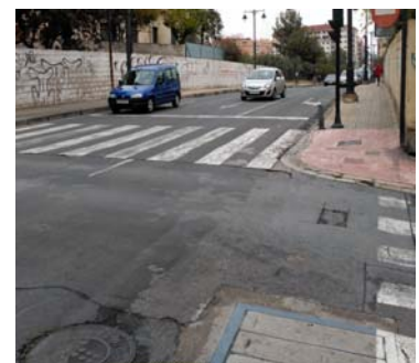
Figura 52. Arquetas existentes de Telefónica en el cruce con la calle Isaac Peral.
