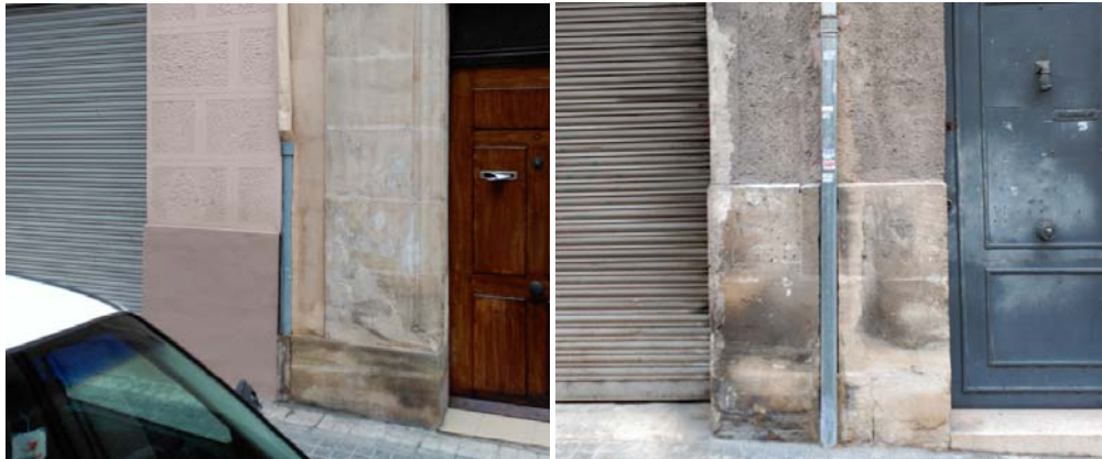
Figura 54. Bajantes adosadas a fachada actualmente existentes.
