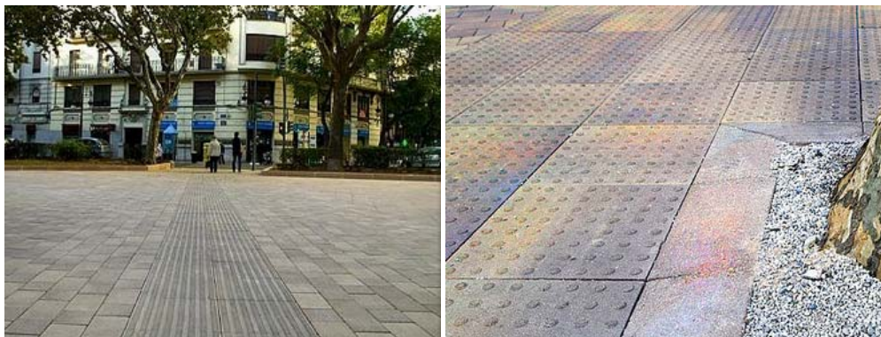
Figura 58. Losa descontaminante de hormigón adaptada a Orden VIV/561/2.010.
