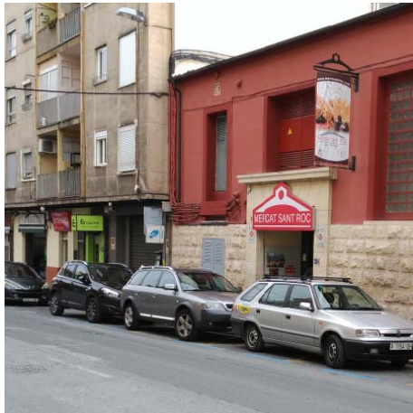
Figura 51. Centro de transformación existente en el Mercat de Sant Roc.
