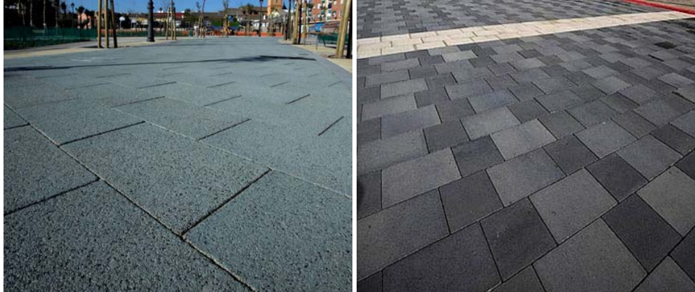
Figura 61. Acabado de aceras mediante losa descontaminante de hormigón.
