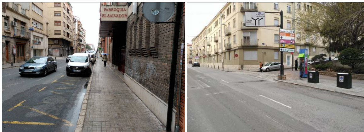
Figura 6. Estado actual de la c/Entença.
