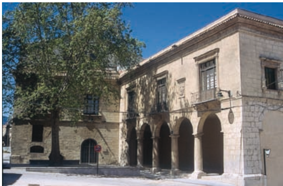
IMATGE ACTUAL DE LA PLACETA DEL CARBÓ I DE L'EDIFICI DEL MUSEU
