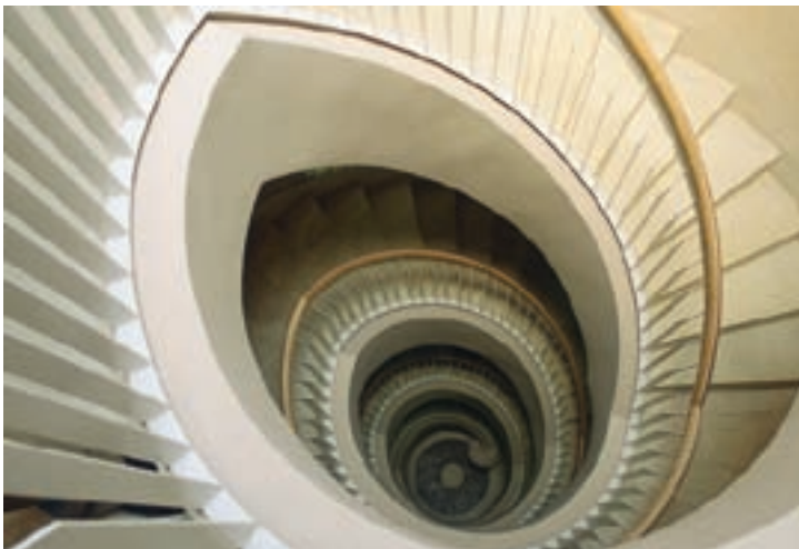
EL PROJECTE DE REHABILITACIÓ VA INCLOURE UNA VISTOSA ESCALA INTERIOR
