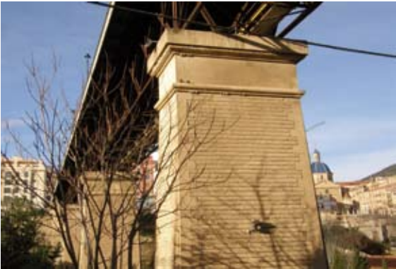
VIADUCTE “te costeres i ponts”
