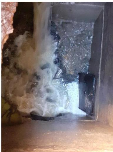
También siguen encontrando pozos en los que se han depositado materiales de construcción como hormigón que supuestamente han sido tirados al finalizar alguna obra. Estos materiales provocan que la red de alcantarillado entre en carga parcial y los lodos pueden llegar a obstruir por completo la tubería.
