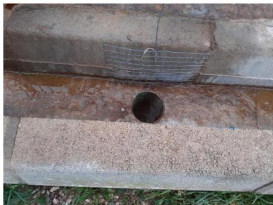
Ejem. Detalle de rejilla instalada pero levantada
