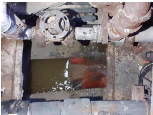
También siguen encontrando pozos en los que se han depositado materiales de construcción como hormigón que supuestamente han sido tirados al finalizar alguna obra. Estos materiales provocan que la red de alcantarillado entre en carga parcial y los lodos pueden llegar a obstruir por completo la tubería.
