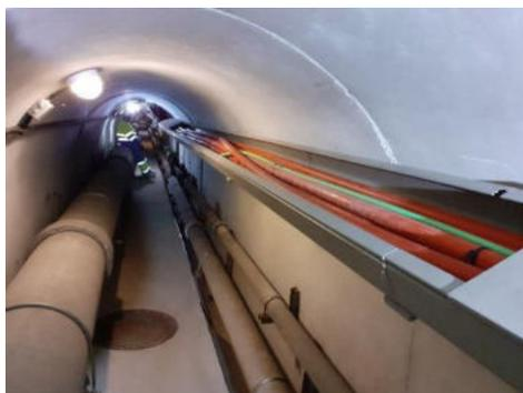
Ejemplo de defecto en galería. Falta tapa cableado
