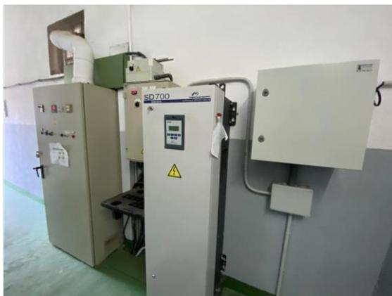
Figura 15. Cuadro de maniobra, variador de frecuencia y telecontrol pozo Molinar 1
