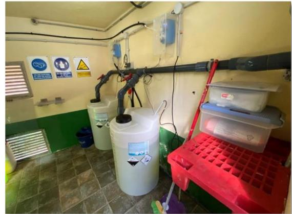
Figura 22. Bombas dosificadoras y depósitos con hipoclorito sódico
