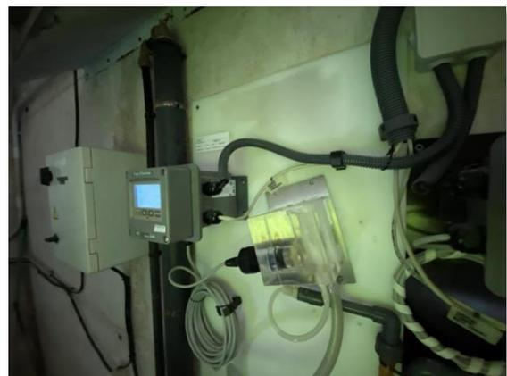
Figura 35. Analizador en continuo de cloro
