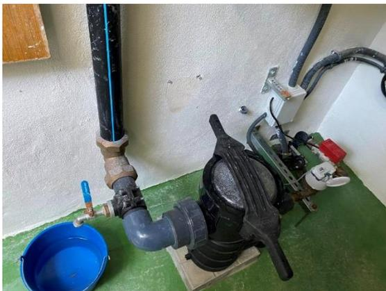
Figura 102. Tubería de entrada con filtro y contador
