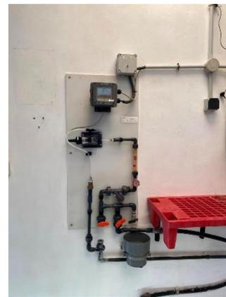
Figura 91. Analizador en continuo de cloro
