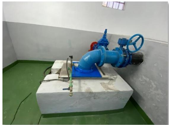
Figura 14. Tubería impulsión y arqueta rotura
