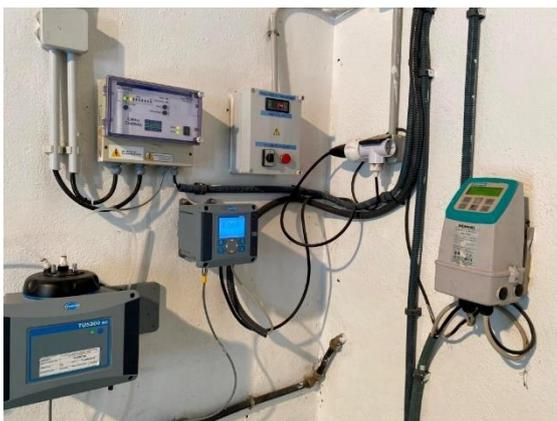
Figura 26. Analizador en continuo de turbidez y totalizador del caudalímetro electromagnético
