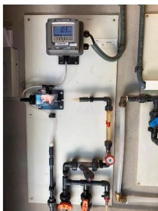
Figura 46. Analizador en continuo de cloro (entrada)
