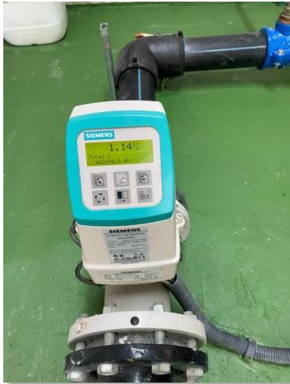
Figura 98. Caudalímetro electromagnético
