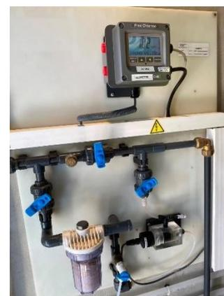
Figura 47. Analizador en continuo (salida)
