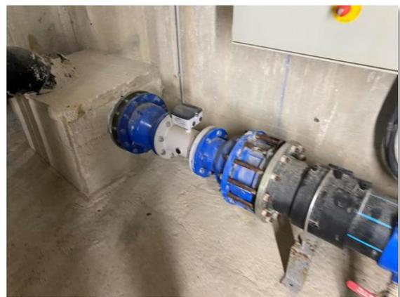
Figura 82. Caudalímetro electromagnético
