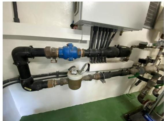
Figura 103. Tubería de salida con contador
