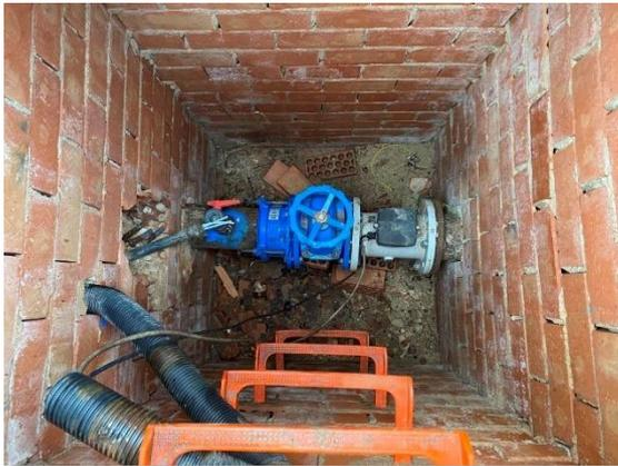
Figura 21. Caudalímetro electromagnético
