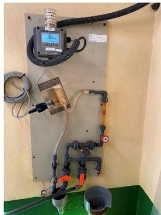
Figura 23. Analizador en continuo de cloro
