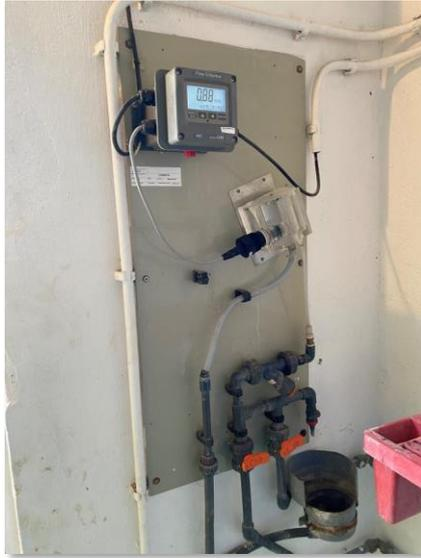
Figura 61. Analizador en continuo de cloro
