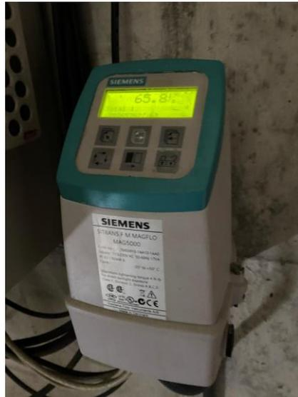
Figura 36. Totalizador del caudalímetro electromagnético
