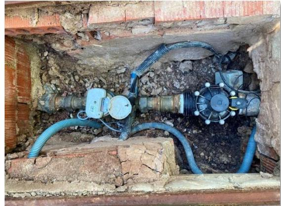
Figura 56. Contador en tubería de entrada y electroválvula
