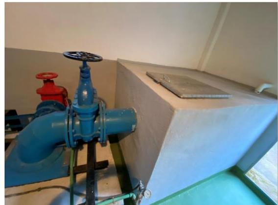
Figura 17. Tubería impulsión y arqueta rotura
