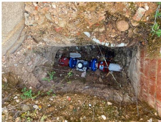
Figura 52. Contador en tubería de salida
