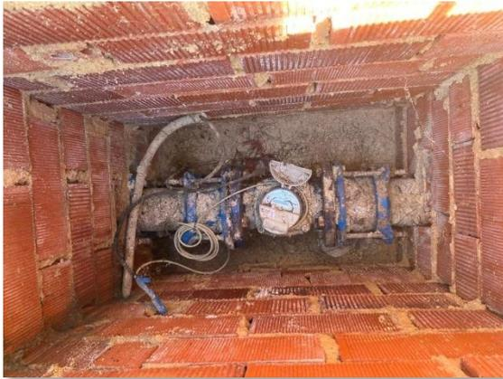
Figura 48. Contador en tubería de entrada
