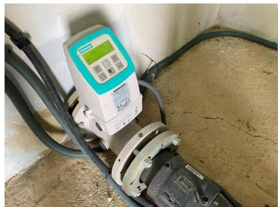
Figura 105. Caudalímetro electromagnético
