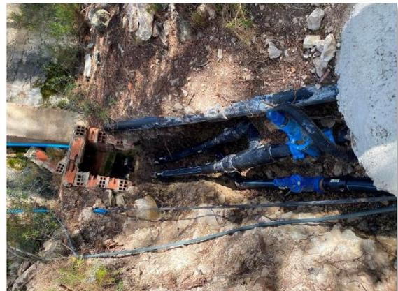
Figura 58. Tubería de salida y desagüe
