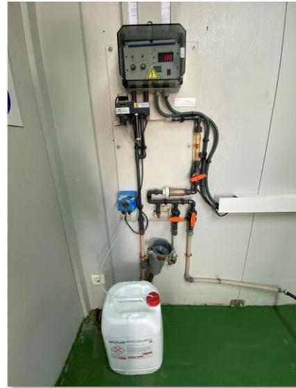
Figura 99. Analizador en continuo de cloro
