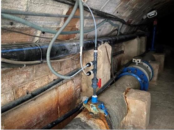
Figura 9. Inyección de hipoclorito y contador electromagnético
