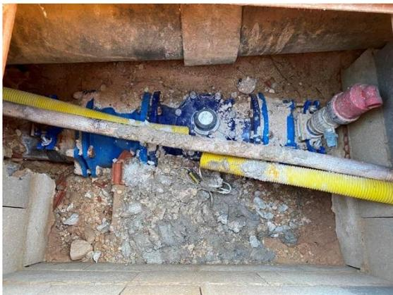
Figura 69. Contador en tubería de salida
