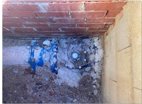
Figura 49. Contador en tubería de salida
