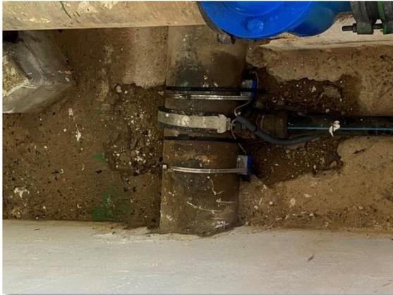
Figura 67. Caudalímetro ultrasónico
