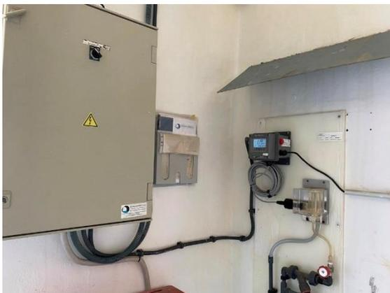
*Figura 39. Analizador en continuo y telecontrol*
