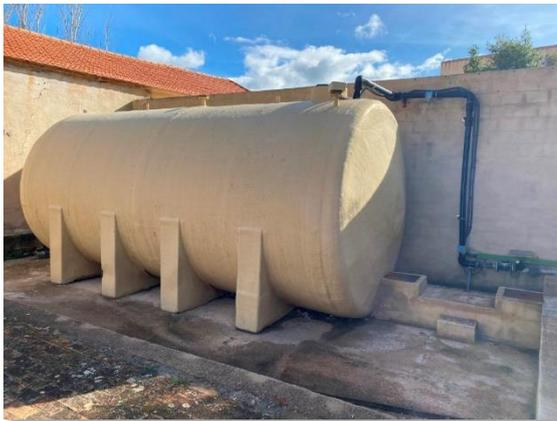
Figura 92. Depósito de aspiración de PRFV
