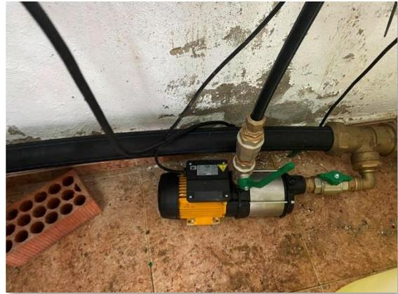
Figura 72. Bomba de recirculación
