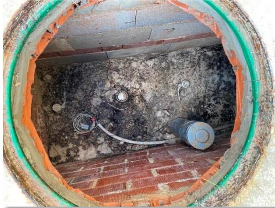
Figura 41. Contador con emisor de pulsos en tubería de salida
