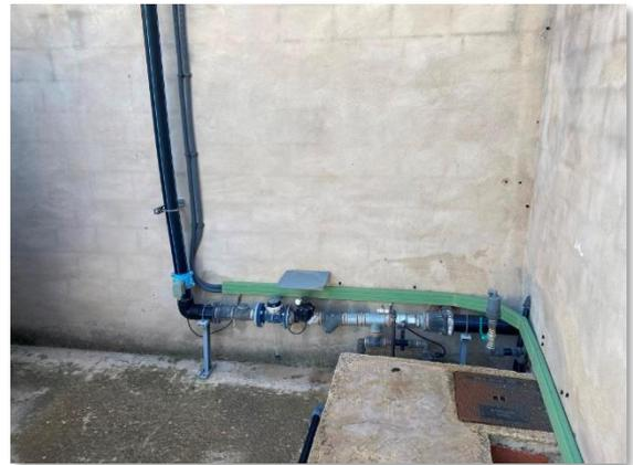
Figura 93. Tubería de entrada con contador y electroválvula
