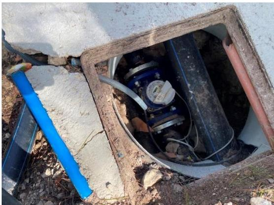
Figura 57. Contador en tubería de salida
