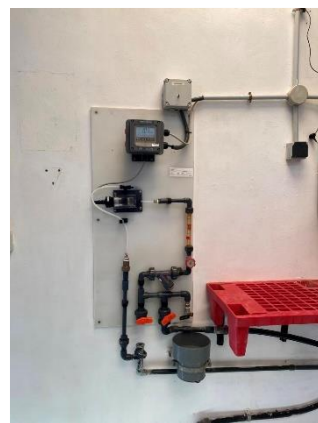
Figura 91. Analizador en continuo de cloro
