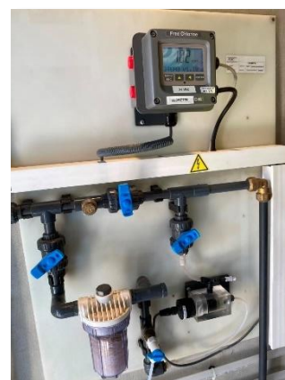
Figura 47. Analizador en continuo (salida)
