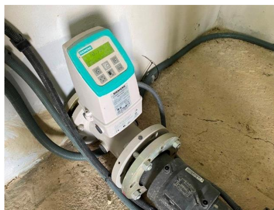
Figura 105. Caudalímetro electromagnético
