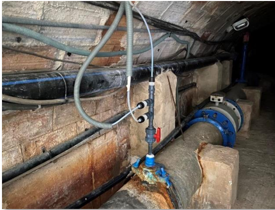
Figura 9. Inyección de hipoclorito y contador electromagnético
