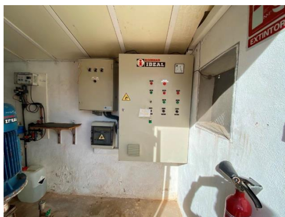
Figura 95. Cuadro de maniobra y analizador en continuo de cloro
