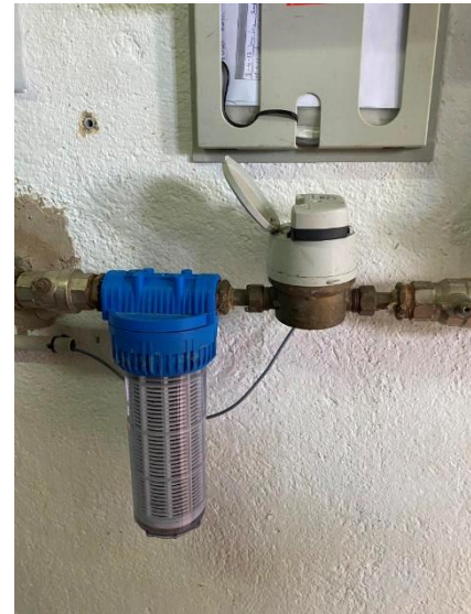
Figura 74. Contador con emisor de pulsos
