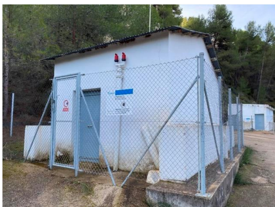
Figura 16. Vista exterior pozo Molinar 2
