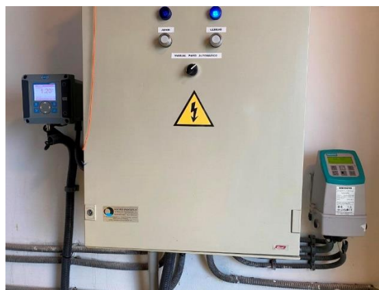
Figura 60. Analizador en continuo de turbidez y totalizador del caudalímetro electromagnético
