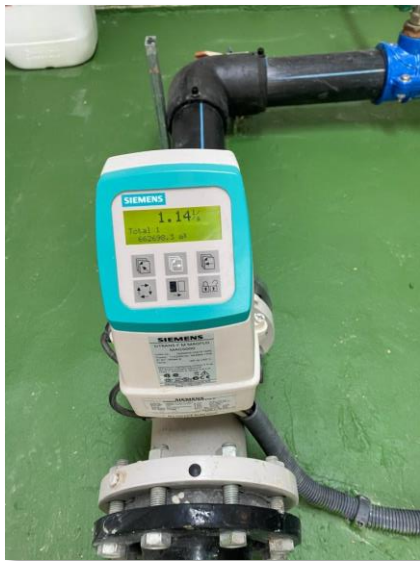
Figura 98. Caudalímetro electromagnético
