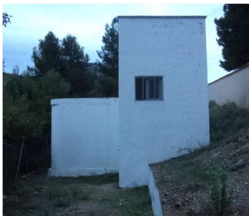
Figura 53. Vista exterior depósito Font de la Salut
