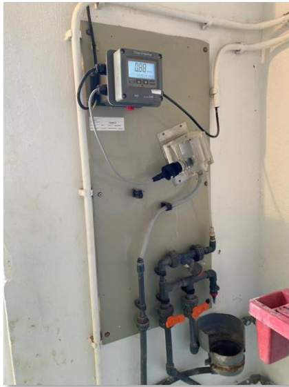
Figura 61. Analizador en continuo de cloro
