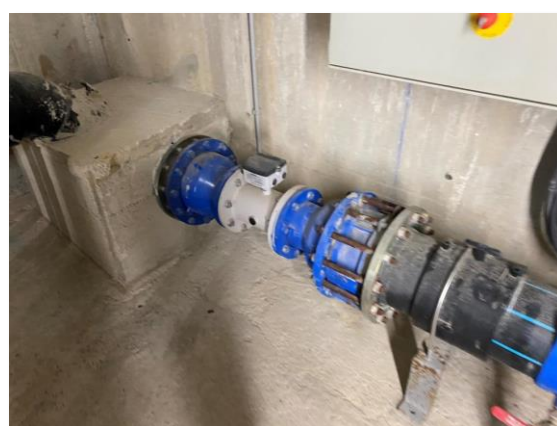
Figura 82. Caudalímetro electromagnético
