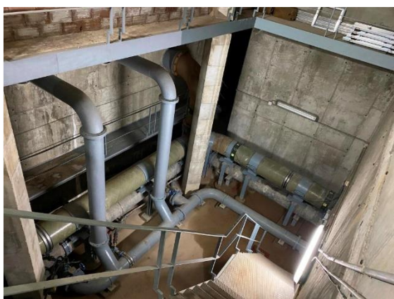
Figura 34. Tubería de entrada, salida, aliviaderos y tuberías de desagüe
