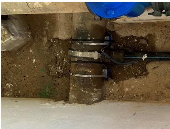
Figura 67. Caudalímetro ultrasónico
