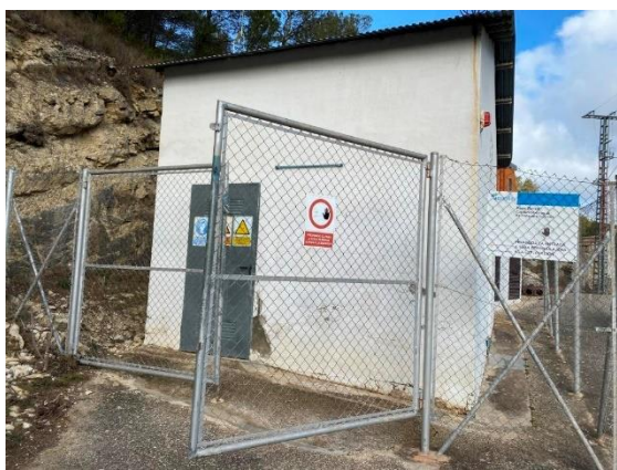
Figura 24. Vista exterior del pozo Barxell
