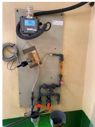
Figura 23. Analizador en continuo de cloro
