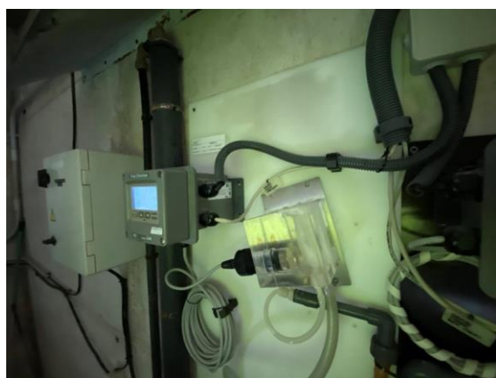
Figura 35. Analizador en continuo de cloro
