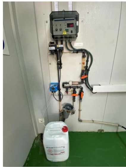
Figura 99. Analizador en continuo de cloro
