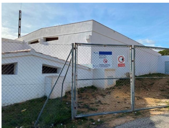
Figura 59. Vista exterior del depósito Batoy
