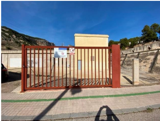
Figura 42. Vista exterior de los depósitos Les Llometes
