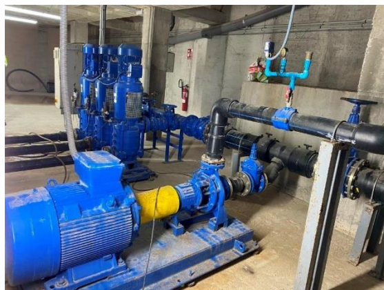
Figura 80. Bomba horizontal de la 2ª etapa
