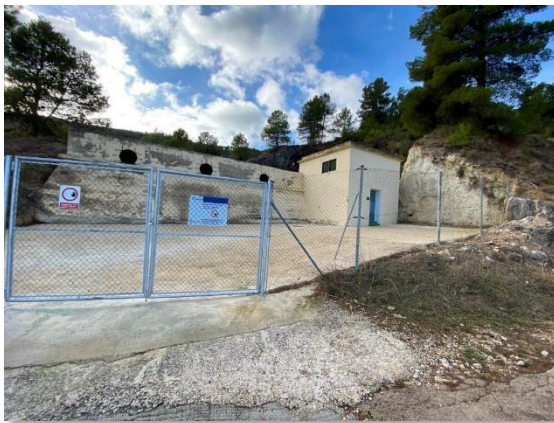
Figura 37. Vista exterior del depósito San Antonio
