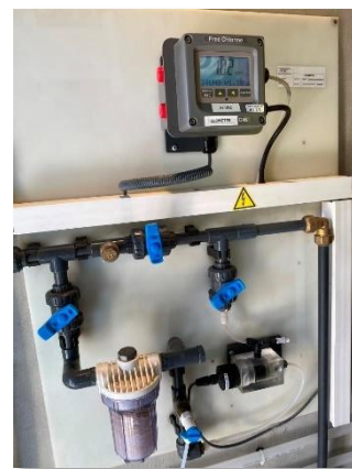
Figura 47. Analizador en continuo (salida)
