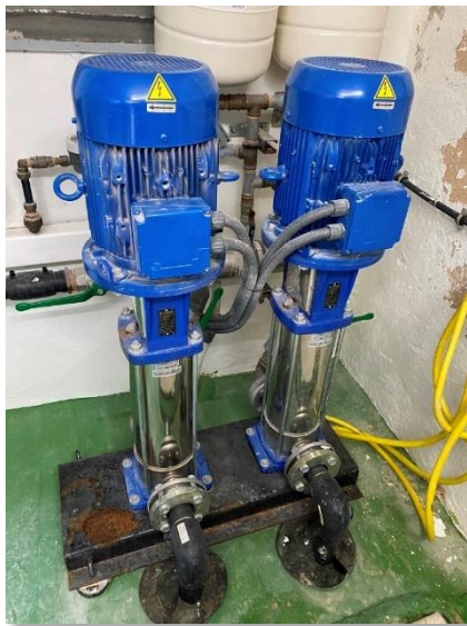
Figura 100. Bombas de la EBAP Xorrador
