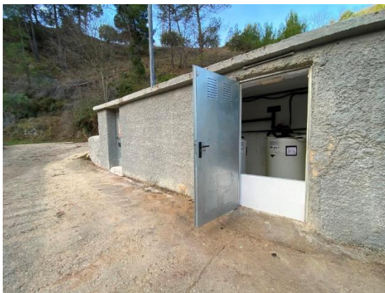
Figura 7. Estación de cloración
