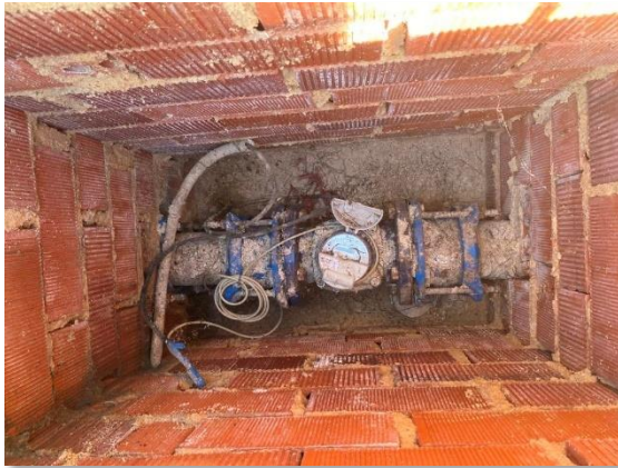
Figura 48. Contador en tubería de entrada
