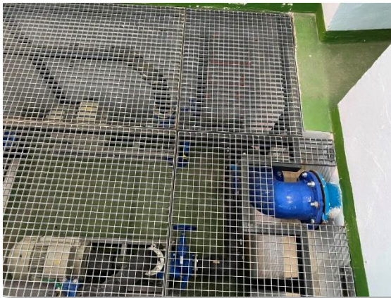
Figura 86. Bombas de la EBAP Arsenal
