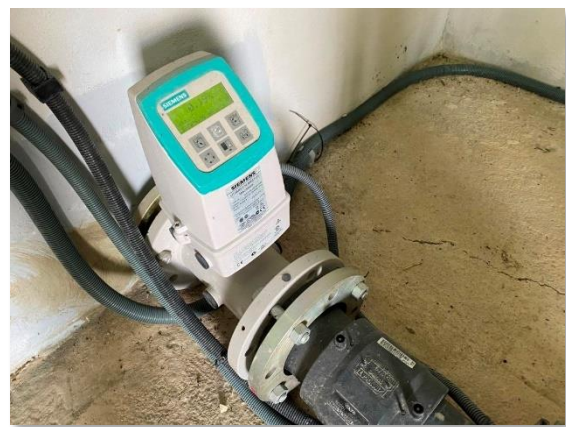
Figura 105. Caudalímetro electromagnético
