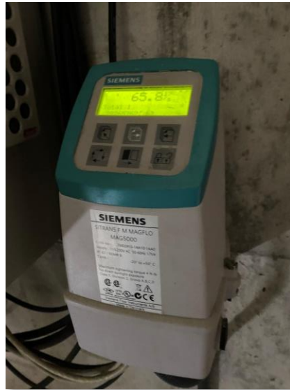
Figura 36. Totalizador del caudalímetro electromagnético
