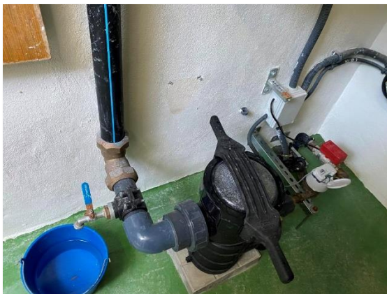
Figura 102. Tubería de entrada con filtro y contador
