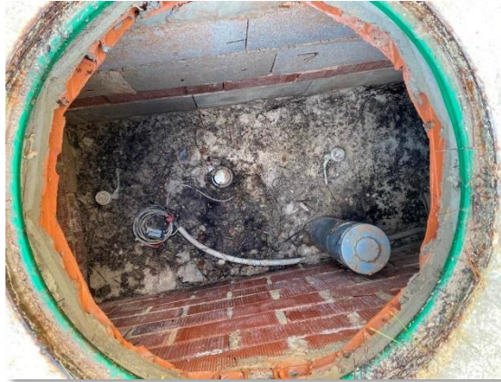
Figura 41. Contador con emisor de pulsos en tubería de salida
