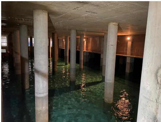
Figura 32. Vaso del depósito Camí
