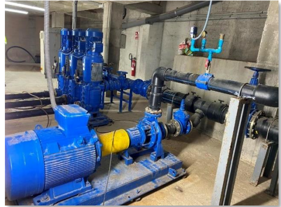
Figura 80. Bomba horizontal de la 2ª etapa
