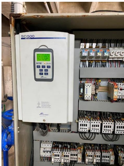
Figura 81. Cuadro con variador de frecuencia
