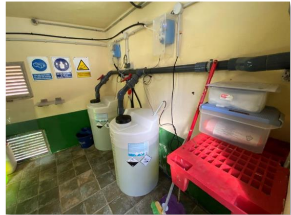
Figura 22. Bombas dosificadoras y depósitos con hipoclorito sódico
