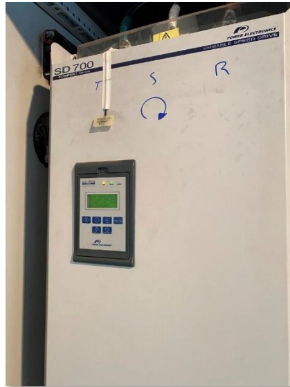
Figura 28. Variador de frecuencia
