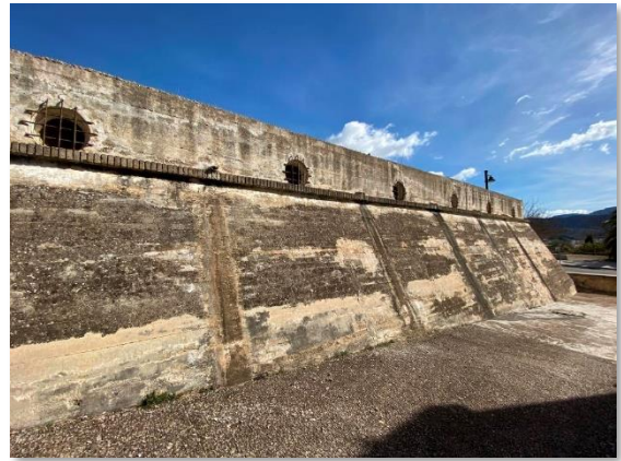
Figura 43. Depósito Les Llometes 1
