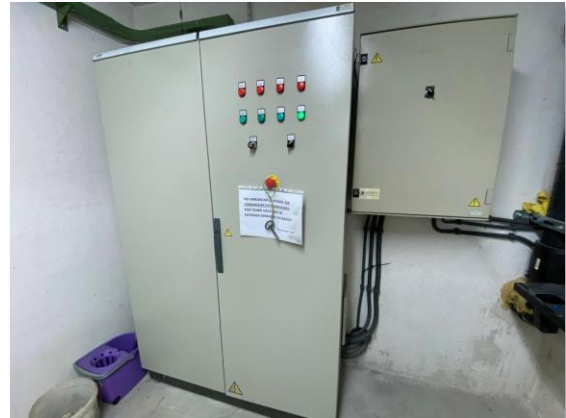
Figura 84. Cuadro de maniobra y telecontrol
