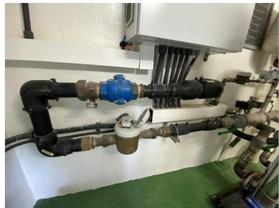
Figura 103. Tubería de salida con contador
