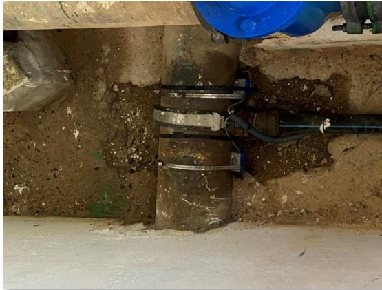
Figura 67. Caudalímetro ultrasónico
