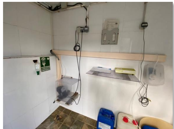
Figura 8. Bombas dosificadoras hipoclorito
