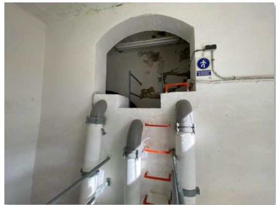
Figura 45. Acceso a los vasos, tuberías de entrada y aliviadero
