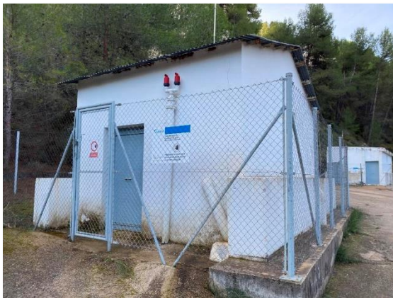
Figura 16. Vista exterior pozo Molinar 2
