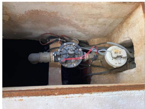
Figura 89. Contador y electroválvula
