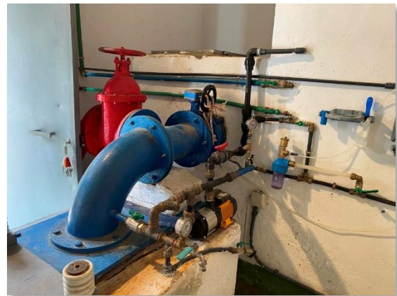
Figura 25. Tubería de impulsión
