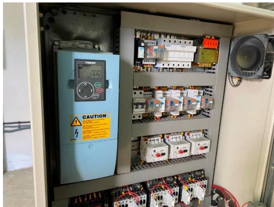
Figura 106. Cuadro de maniobra y variador de frecuencia
