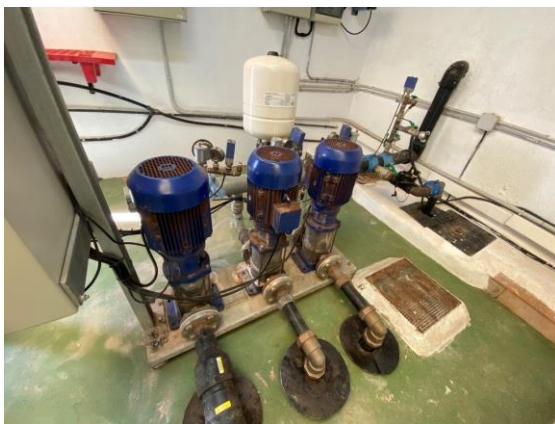
Figura 88. Bombas de la EBAP Olivar Bassa
