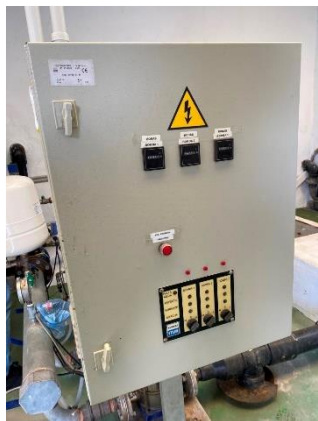
Figura 90. Variador de frecuencia
