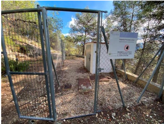
Figura 55. Vista exterior depósito Preventorio
