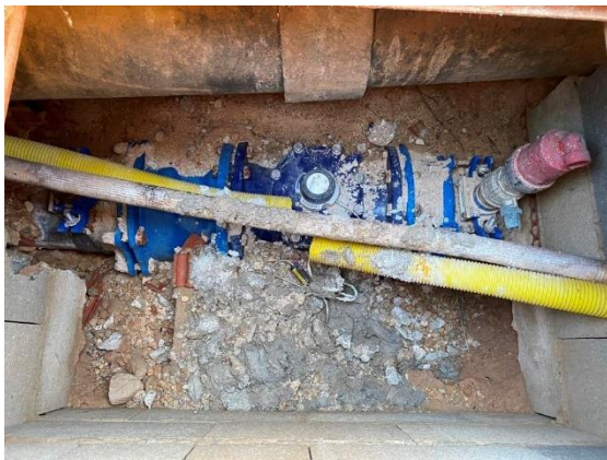
Figura 69. Contador en tubería de salida
