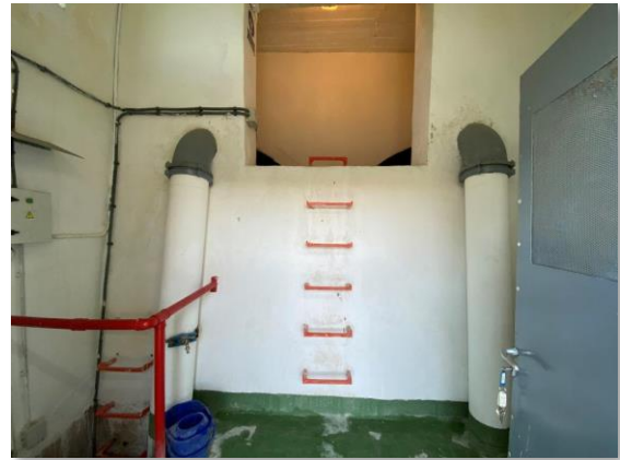
Figura 38. Tuberías de entrada al depósito
