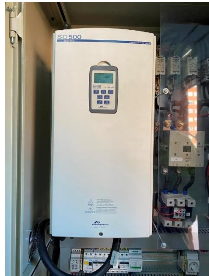
Figura 87. Cuadro con variador de frecuencia
