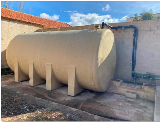
Figura 92. Depósito de aspiración de PRFV
