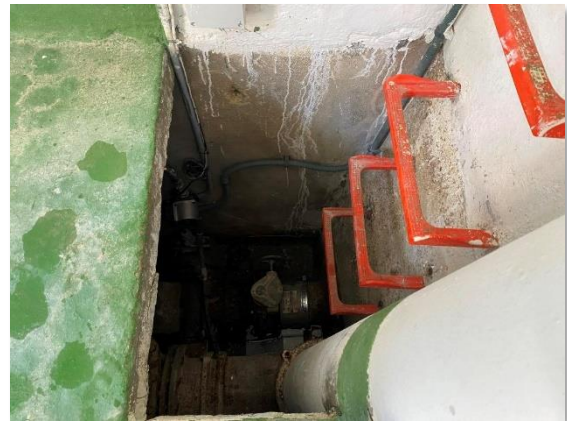
Figura 40. Tubería de salida del depósito
