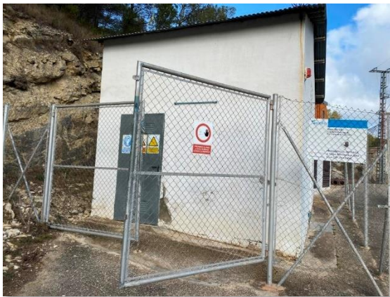
Figura 24. Vista exterior del pozo Barxell
