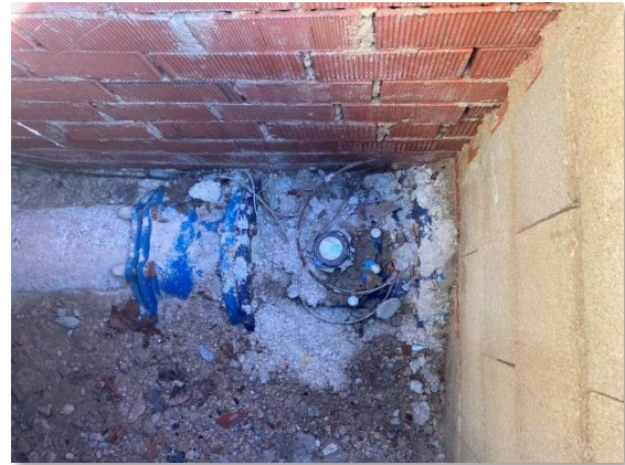
Figura 49. Contador en tubería de salida
