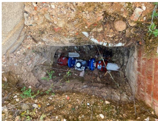
Figura 52. Contador en tubería de salida
