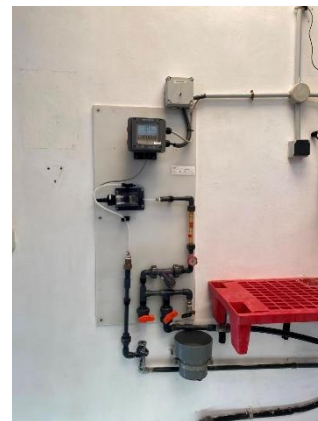
Figura 91. Analizador en continuo de cloro
