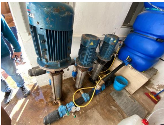
Figura 94. Bombas de la EBAP Preventorio
