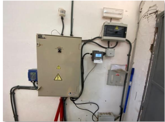
Figura 68. Telecontrol, analizador en continuo de cloro y totalizador del caudalímetro ultrasónico
