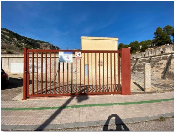
Figura 42. Vista exterior de los depósitos Les Llometes
