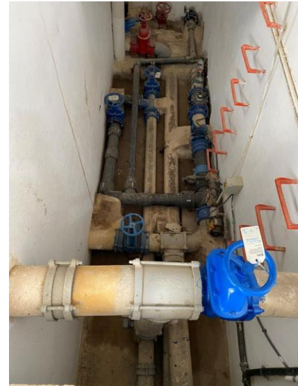
Figura 64. Tuberías de entrada y salida
