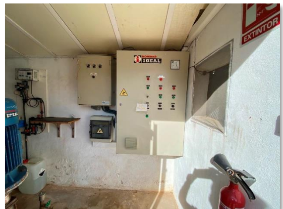
Figura 95. Cuadro de maniobra y analizador en continuo de cloro
