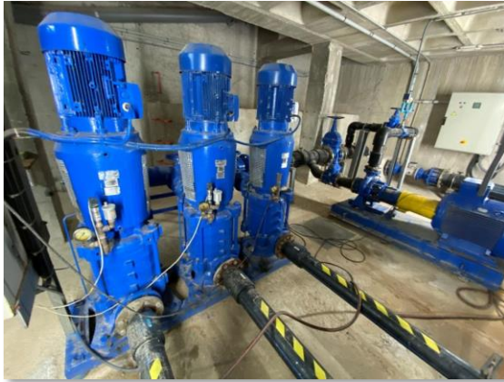
Figura 79. Bombas verticales de la EBAP Camí
