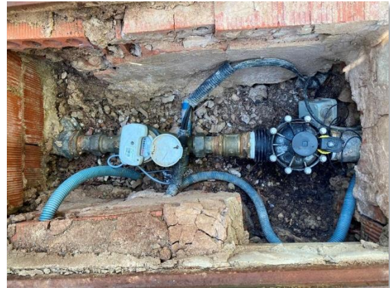
Figura 56. Contador en tubería de entrada y electroválvula
