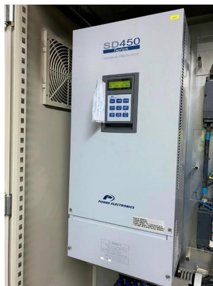
Figura 85. Variador de frecuencia
