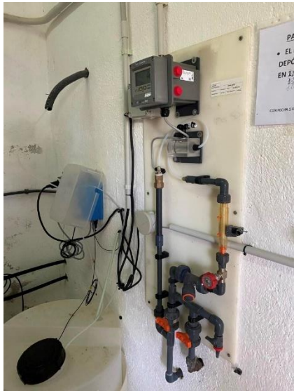
Figura 73. Bomba dosificadora y analizador en continuo de cloro
