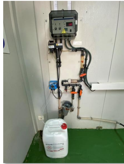
Figura 99. Analizador en continuo de cloro
