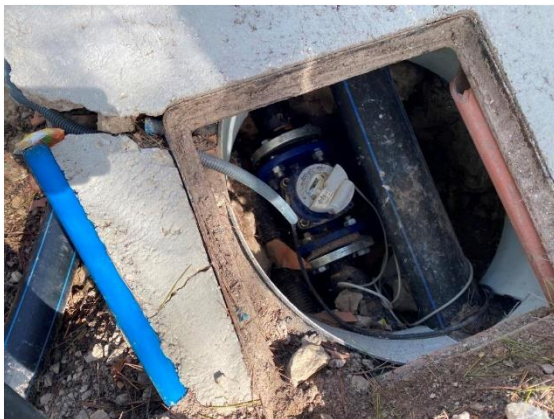
Figura 57. Contador en tubería de salida
