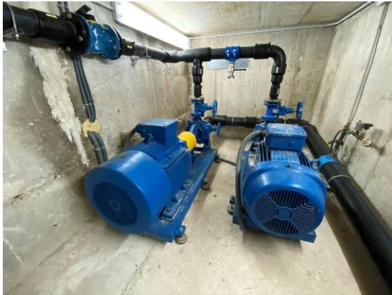
Figura 83. Bombas de la EBAP Nodriza
