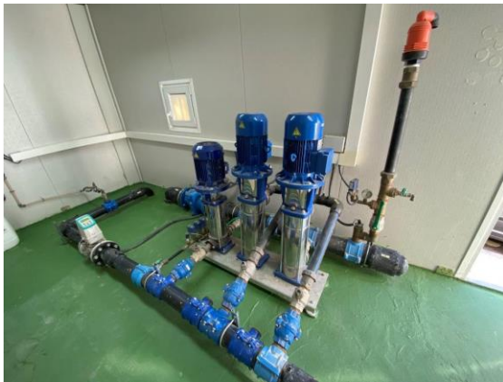
Figura 96. Bombas de la EBAP San Juan de Ribera
