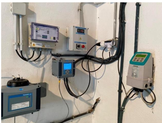
Figura 26. Analizador en continuo de turbidez y totalizador del caudalímetro electromagnético
