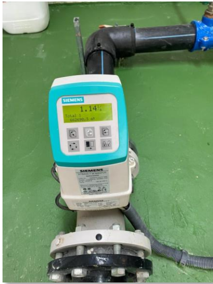
Figura 98. Caudalímetro electromagnético
