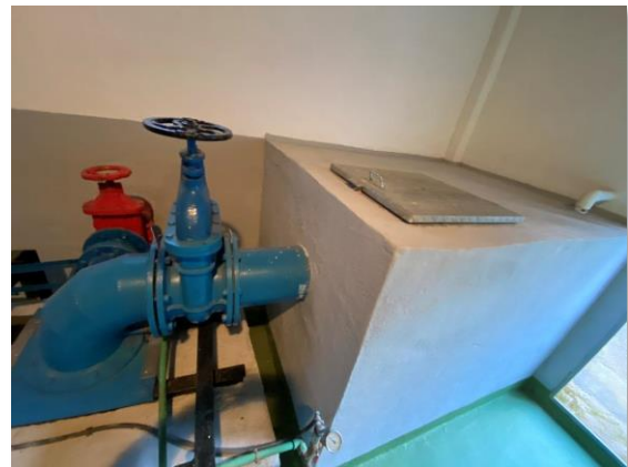
Figura 17. Tubería impulsión y arqueta rotura
