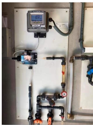
Figura 46. Analizador en continuo de cloro (entrada)
