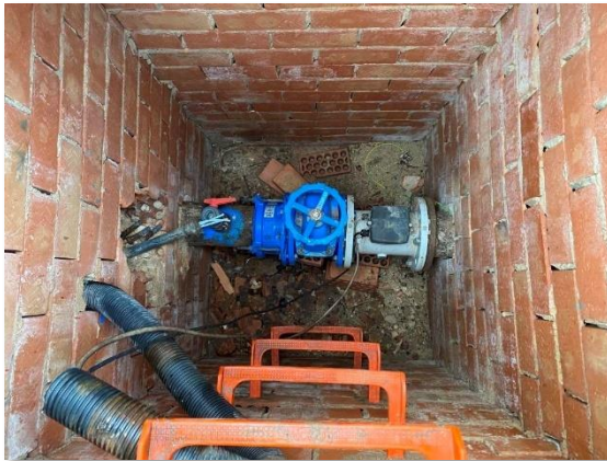
Figura 21. Caudalímetro electromagnético
