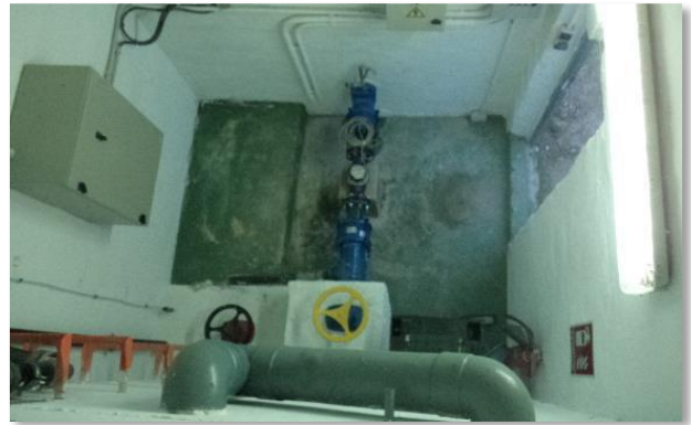
Figura 54. Cámara de válvulas depósito Font de la Salut
