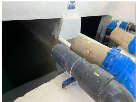
Figura 66. Vasos del depósito Llençols
