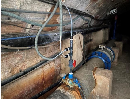
Figura 9. Inyección de hipoclorito y contador electromagnético
