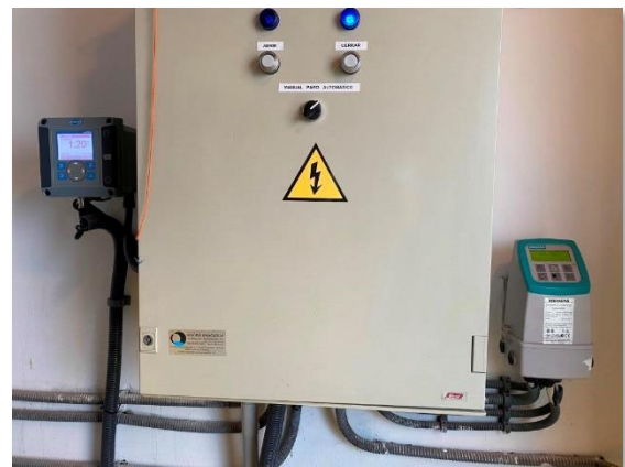
Figura 60. Analizador en continuo de turbidez y totalizador del caudalímetro electromagnético
