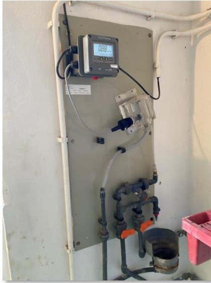
Figura 61. Analizador en continuo de cloro
