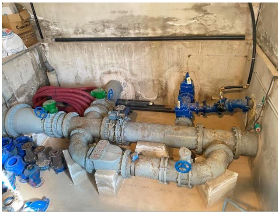
Figura 44. Tuberías de salida
