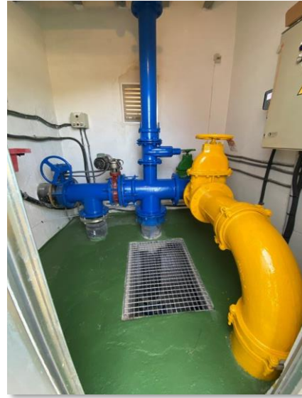
Figura 62. Conducción de entrada
