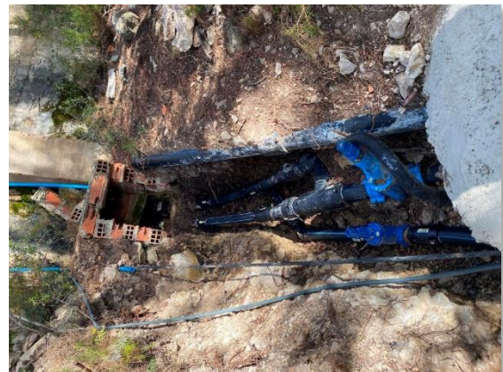
Figura 58. Tubería de salida y desagüe
