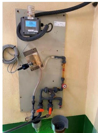
Figura 23. Analizador en continuo de cloro
