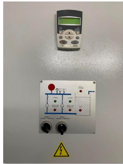
Figura 101. Cuadro de maniobra con variador de frecuencia
