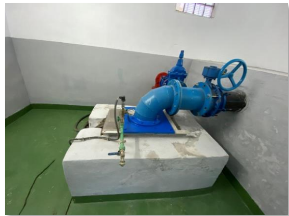
Figura 14. Tubería impulsión y arqueta rotura
