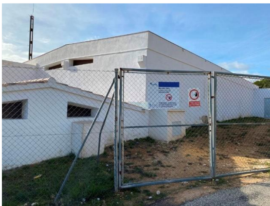
Figura 59. Vista exterior del depósito Batoy
