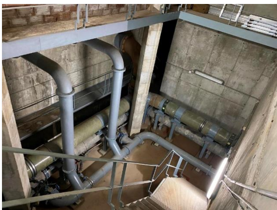
Figura 34. Tubería de entrada, salida, aliviaderos y tuberías de desagüe
