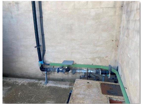
Figura 93. Tubería de entrada con contador y electroválvula
