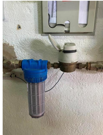
Figura 74. Contador con emisor de pulsos
