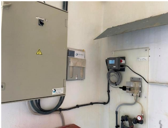
Figura 39. Analizador en continuo y telecontrol
