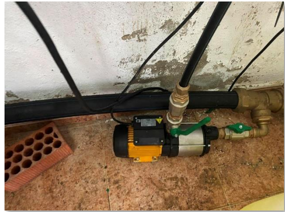
Figura 72. Bomba de recirculación
