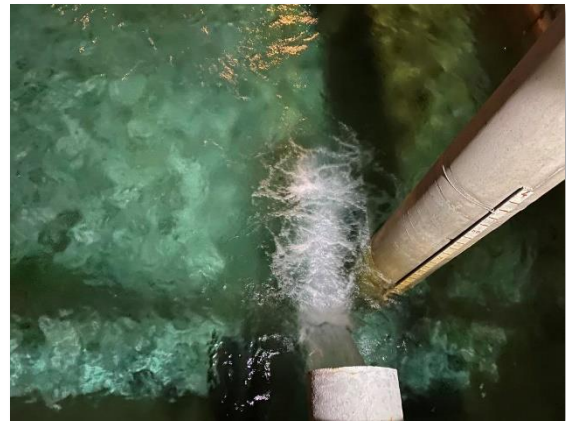
Figura 33. Tubería de entrada de agua al depósito
