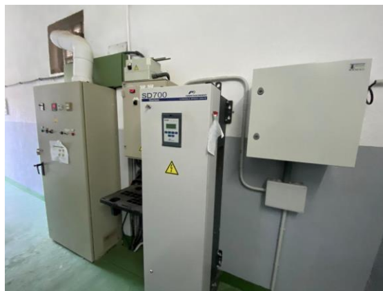
Figura 15. Cuadro de maniobra, variador de frecuencia y telecontrol pozo Molinar 1
