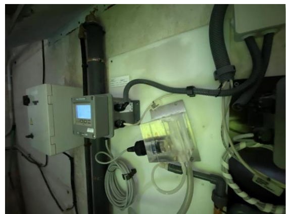
Figura 35. Analizador en continuo de cloro
