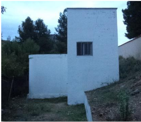
Figura 53. Vista exterior depósito Font de la Salut
