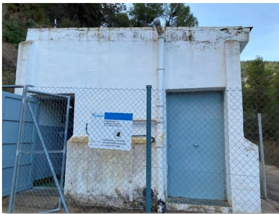
Figura 13. Vista exterior pozo Molinar 1
