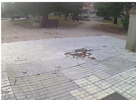
*Imagen n°01.-* Ejemplo de estado de pavimento en acceso.
