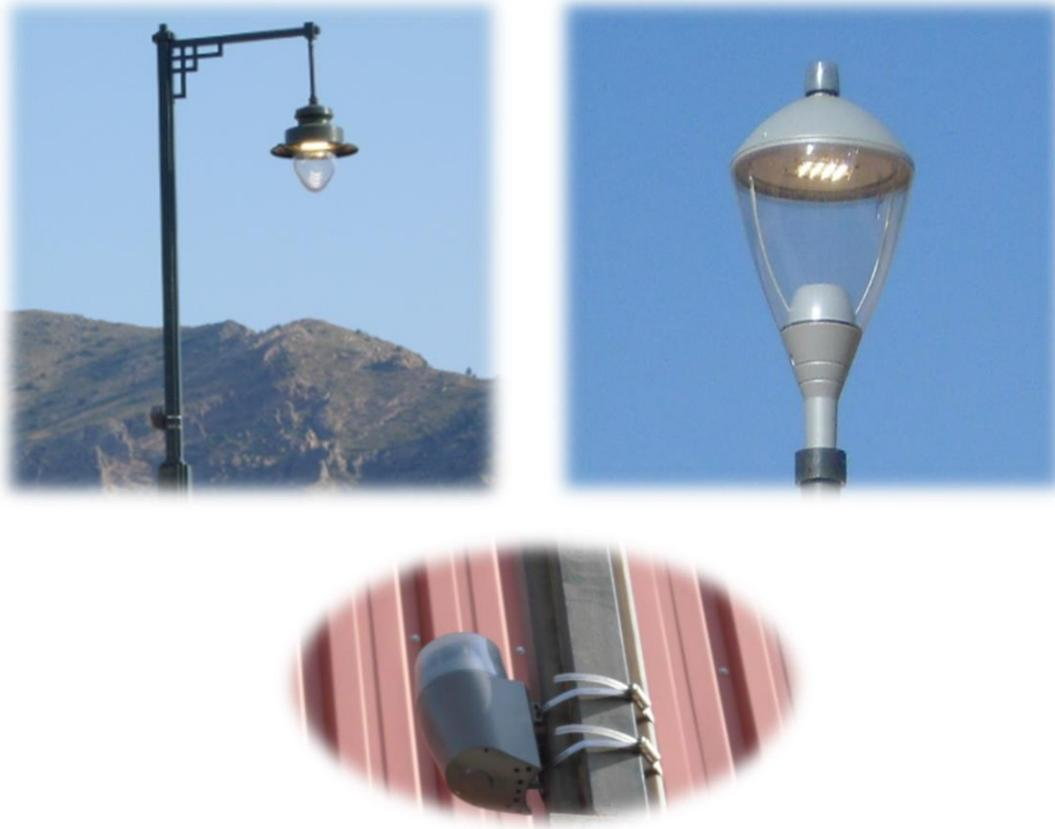
**Ilustración 3. Luminarias con nodos de comunicación instalados**
