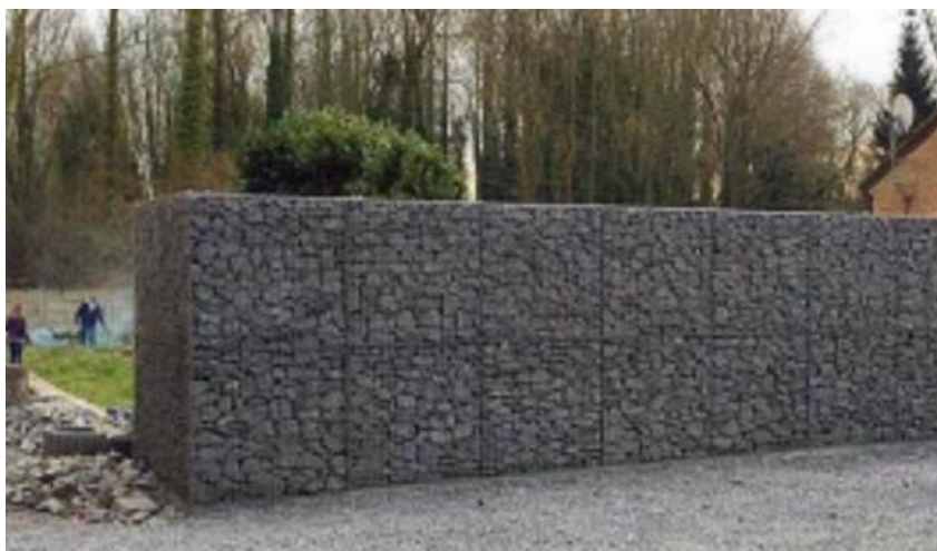
Imagen descriptiva de tipo de muro de gaviones. Fuente. - Ayuntamiento de Alcoi.
