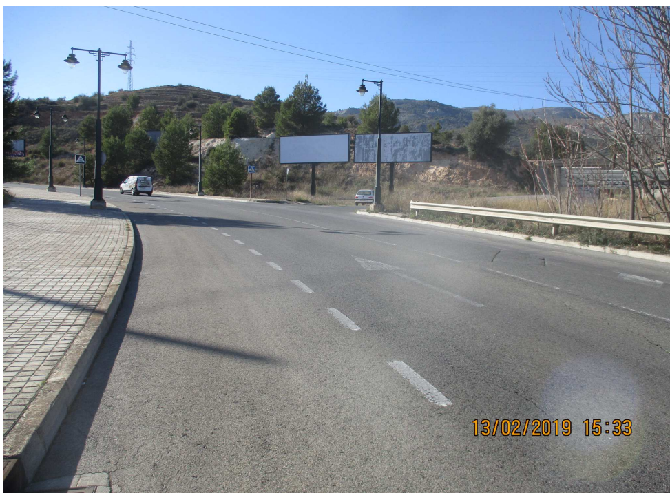
Foto nº.4 avenida Tirant Lo Blanch
