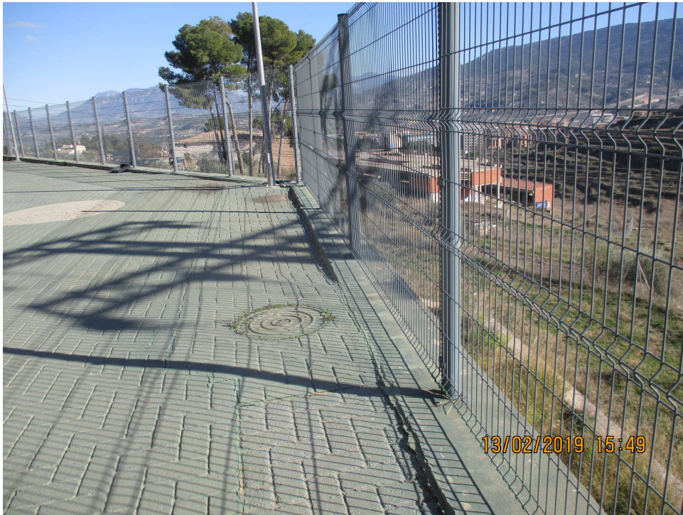
Foto nº.20 pozo de registro situado dentro del Centro Ocupacional.
