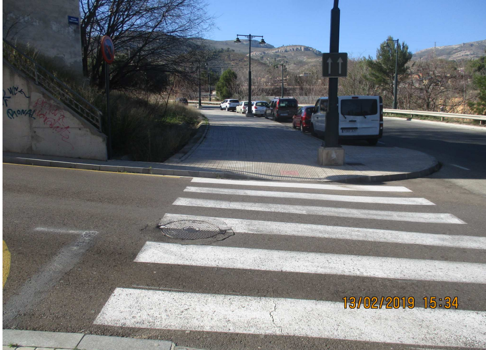
Foto nº.3 Inicio de la obra en la avenida Tirant Lo Blanch
