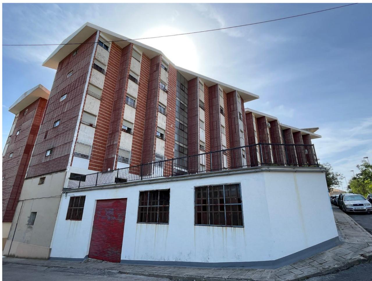
Ilustración 15 Bloque 12 en C/ Mestre Faus con revestimiento de placas de fibrocemento en fachadas noreste.
