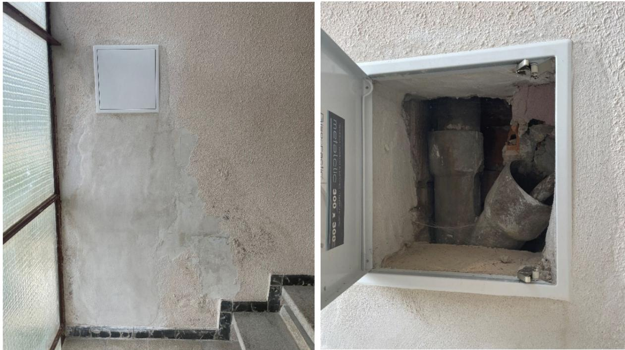
Ilustración 18 Bloque 12 en C/ Mestre Faus. Reparación de bajante empotrada con registro para mantenimiento.
