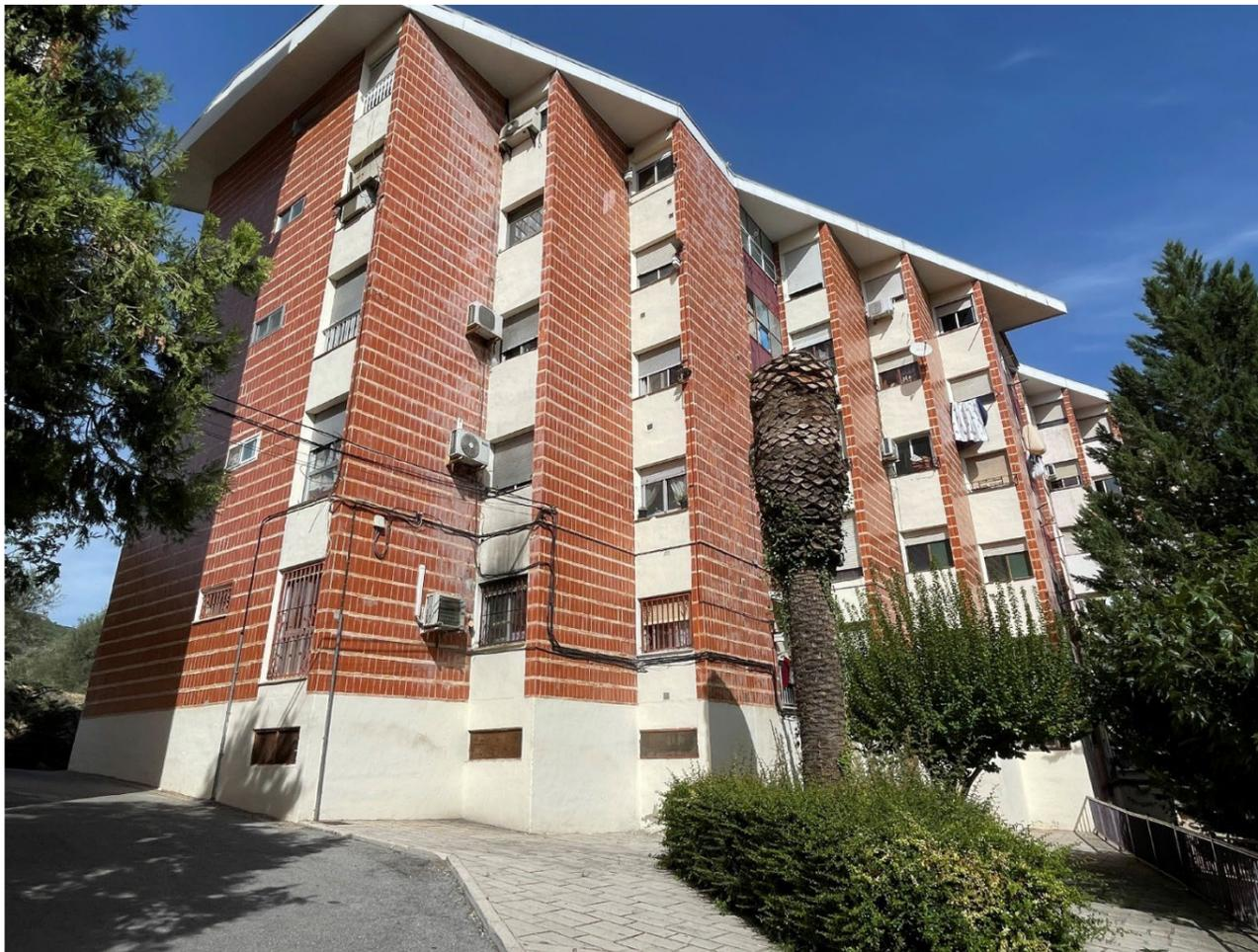
Ilustración 16 Bloque 6 en C/ Mestre Faus con varios equipos exteriores de aire acondicionado instalados en fachada.
