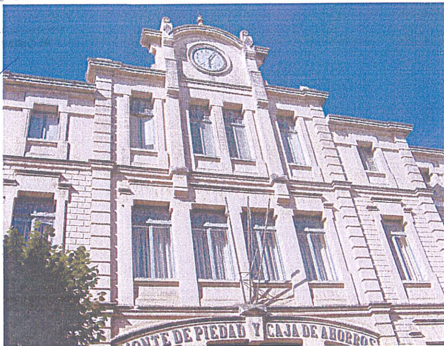
Fotografía nº 10. Detalle de la parte central de la fachada principal. Plantas 1ª y 2ª.
