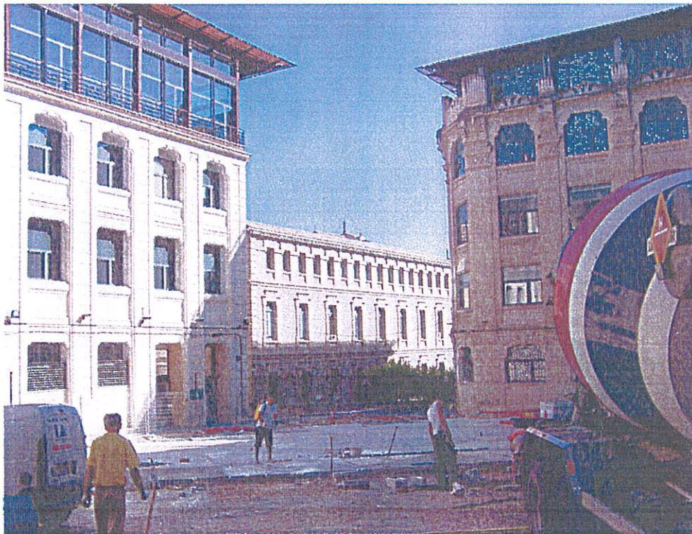
Fotografía nº 2. Vista del edificio desde la Plaza de Ferrándiz y Carbonell encarando el cruce de las calles Bartolomé J. Gallardo y Juan Cantó. Se ve el plano de la fachada lateral del edificio inclinada con respecto al eje diagonal de la plaza.
