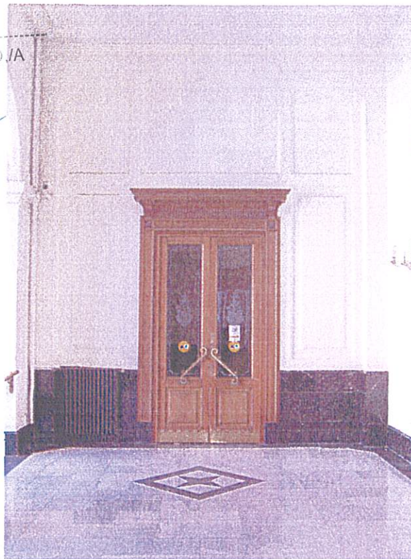
Fotografía nº 18. Detalle de puerta del vestíbulo principal Planta Baja.
