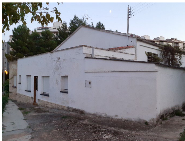
Ilustración 5. Hangar a demoler. Fachada Norte.
