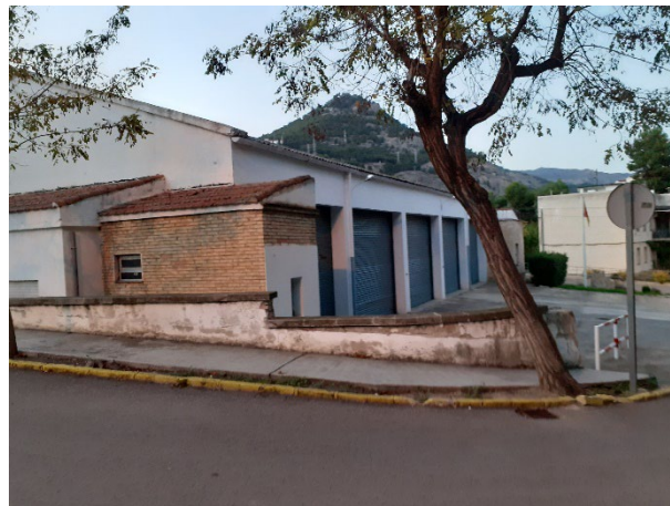
Ilustración 3. Hangar a demoler. Fachadas Este y Sur.
