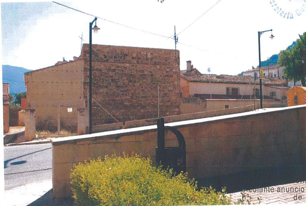
Foto 4. Fachada noreste. Calle Sotarroni
