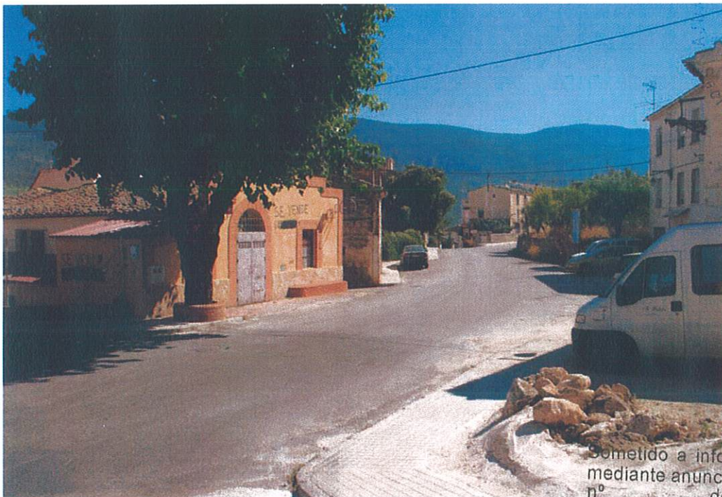
Foto 8. Trazado de la antigua carretera de Banyeres
