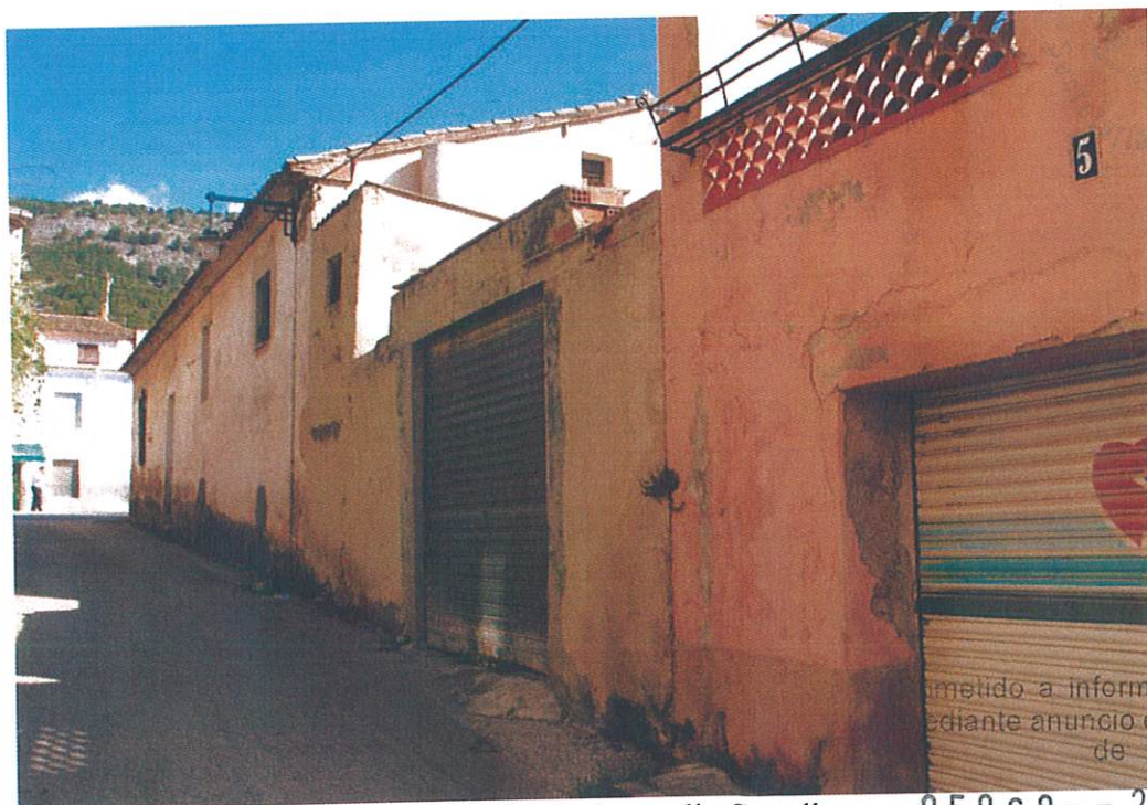
Foto 14. Propiedades particulares. Fachada a calle Castellar
