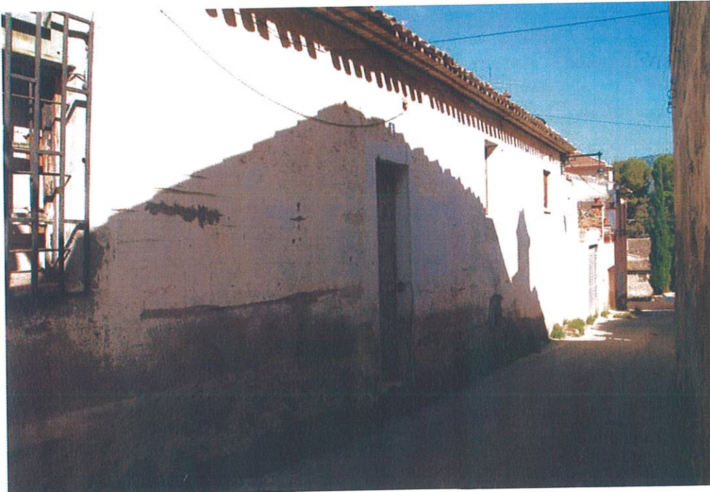
Foto 6. Fachada suroeste. Calle Castellar
