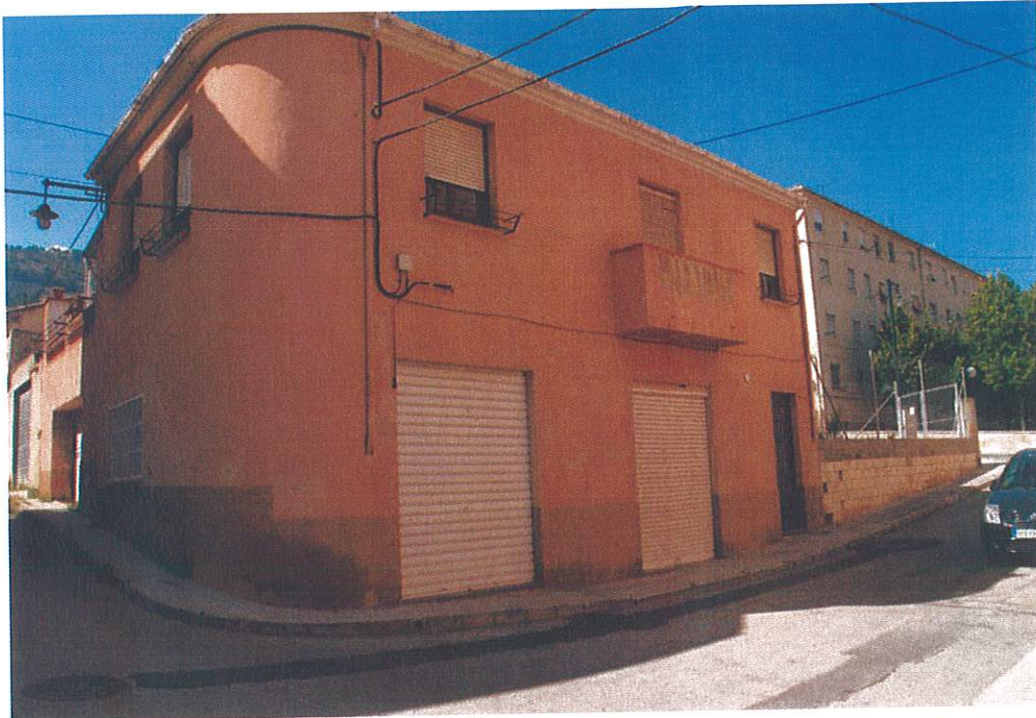
Foto 5. Fachada sureste. Calle Serrella
