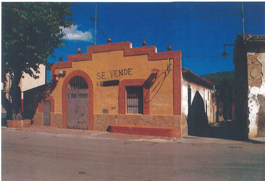
Foto 7. Fachada noroeste. Calle Banyeres
