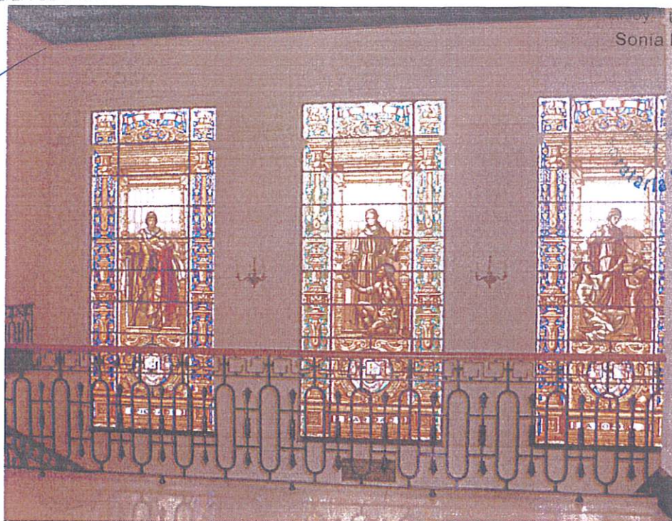
Fotografía nº 15. Detalle de las vidrieras del vestíbulo principal, vistas desde el vestíbulo de la planta primera.
