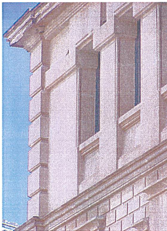
Fotografía nº 8. Detalle esquina (J. Cantó, D. Fdez. Montañés) en el que se observa el volumen de las molduras de los elementos de la fachada.
