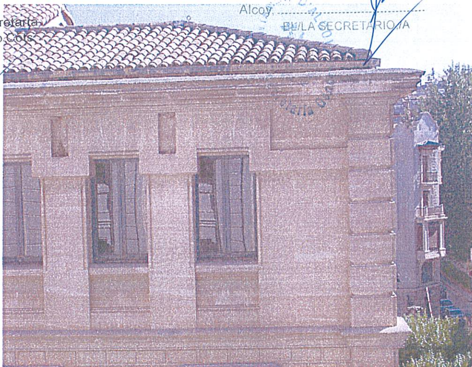
Fotografía nº 7. Detalle de la esquina (J. Cantó, B. J. Gallardo) de la fachada en planta segunda, con cornisa, canalón y faldón de cubierta
