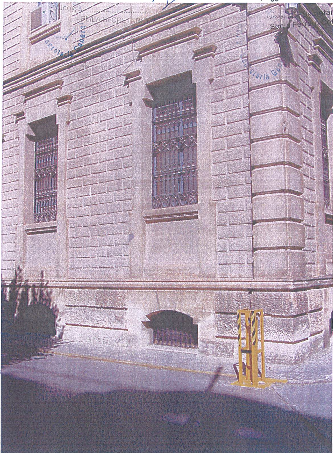
Fotografía nº 12. Detalle de la esquina (R. Albors, B. J. Gallardo), con imagen del hueco tipo de Planta Baja y Planta Semisótano.
