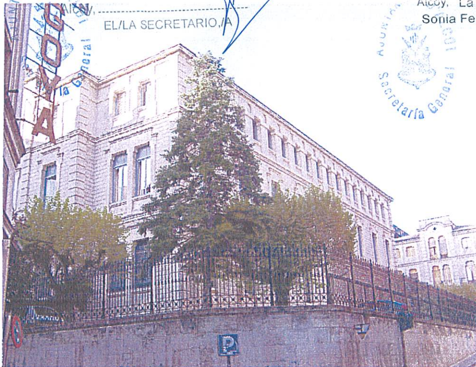
Fotografía nº 1. Vista del edificio desde la esquina de las calles Rigoberto Albers y Diego Fernández Montañés. Obsérvese la naturaleza del muro y la verja de cierre de la alineación de la manzana en estas dos calles y la presencia exenta del edificio retirado de estas alineaciones.
