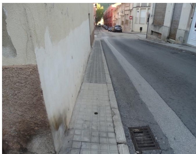
Il·lustració 10 – Exemple mal estat via pública i no-amplària
