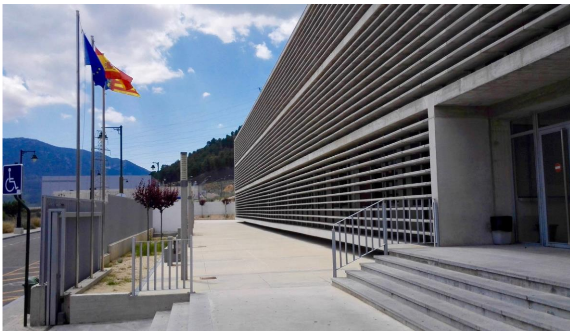
Il·lustració 18 – Instal·lacions del CIP FP Batoi
