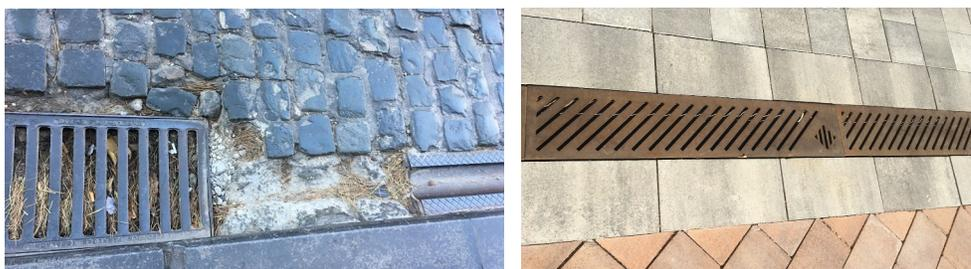
Unificación de la calzada por una plataforma peatonal y sustitución de los imbornales
